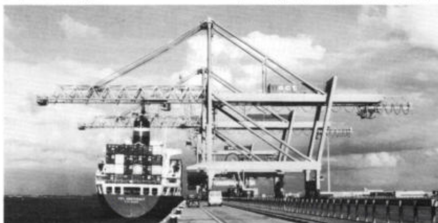
Siemens leverde voor 11 containerkranen de complete elektrische installatie, inclusief de montage en inbedrijfstelling.
